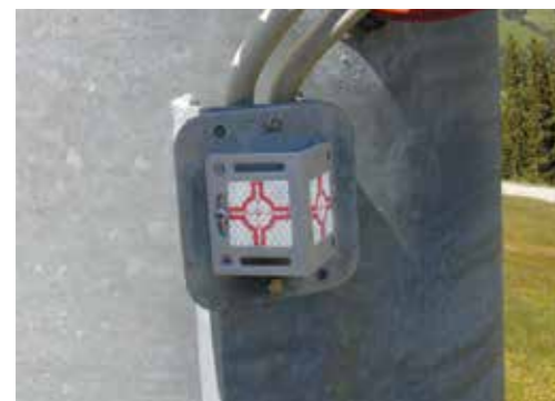
Punto de medición en soporte de telesquí
