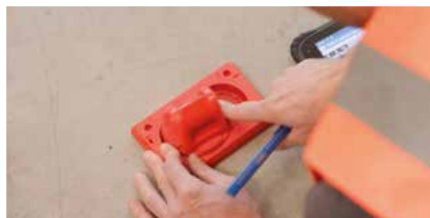
Mueva el prisma hacia un lado y marque la posición del objetivo con un lápiz
