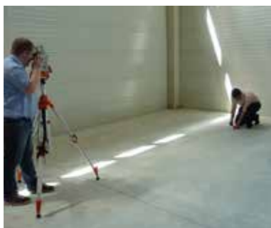
RS95 – Trabajos de trazado en las camillas de replanteo.
