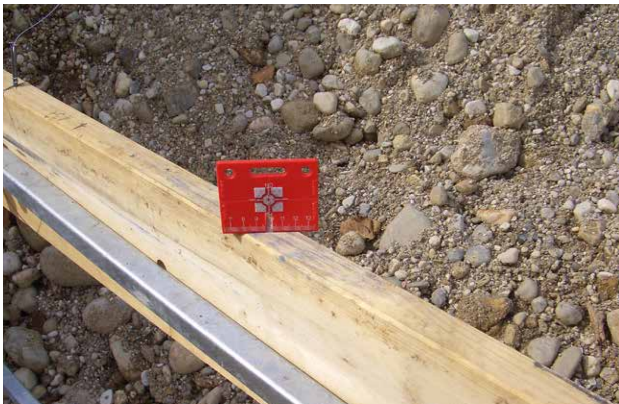
RS95 – Trabajos de trazado en las camillas de replanteo.
