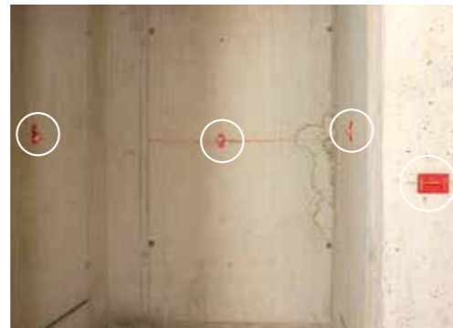
RS AK130 y RS21: puntos de referencia perfectos para la línea de nivel y los ejes en la zona del ascensor
