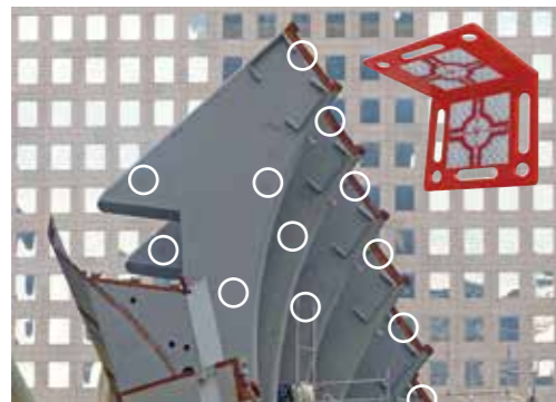
RS90r, estación de metro del World Trade Center
