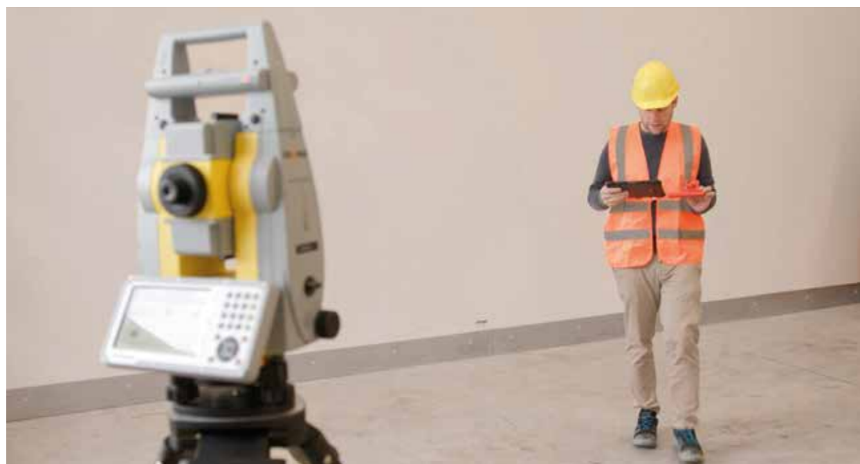
Replanteo con la RS150M y la estación total robotizada
